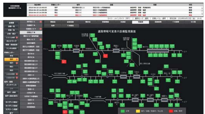
画面2. 道路可変表示設備監視画面例
